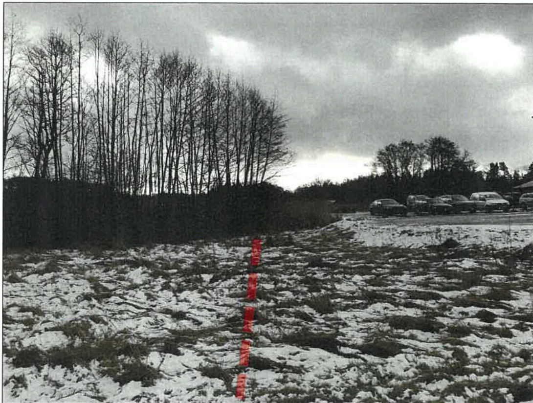
Figur 15. Foto som visar var ledningen ska gå genom öppen mark innan skarvning sker från mark- till sjökabel. Kyrksundet är beläget bakom trädridån. En ledningssträckning exemplifieras med röd streckad linje.
